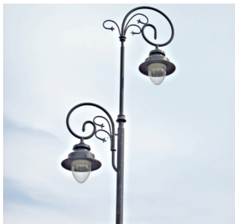
En äldre elegant gatubelysning. En utmaning för klensmeder. Själva armaturen görs enligt beskrivningarna i detta avsnitt. Stolpen kräver nog att man låter etsa vissa delar – i varje fall om de rör sig om flera stolpar. Warszawa, 2013
