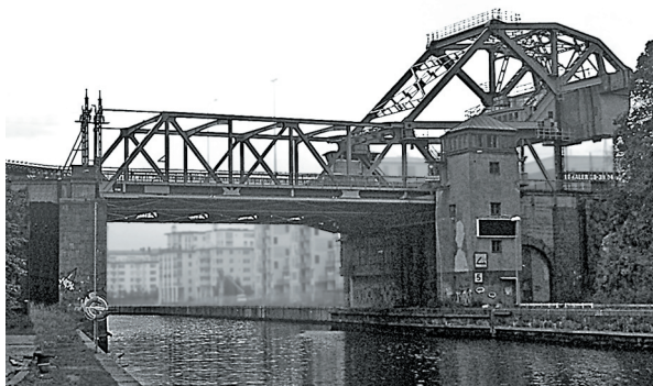
Klaffbro i stålkonstruktion Danvikstull, Stockholm. Bron har en överliggande motvikt av betong.
