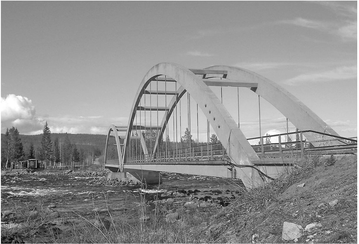
Tvåspannig betongbro över Abmoälven. Brobanan är tillika dragband.
