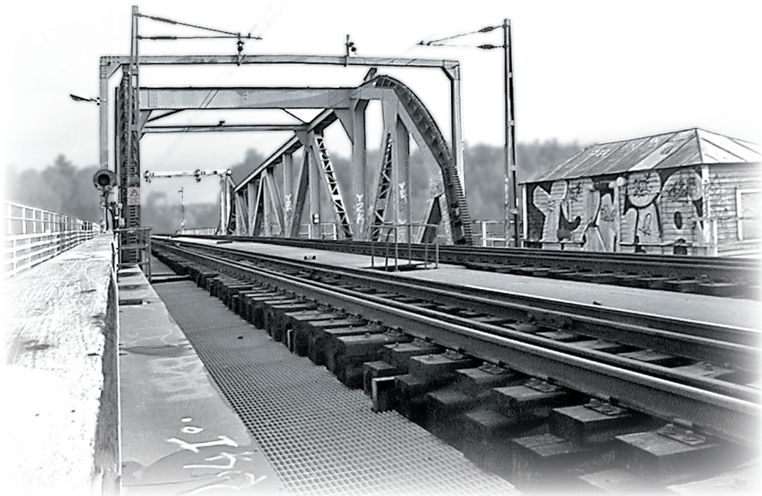
Dubbelspårig klaffbro, Södertälje. Gångbanan vid sidan av spåren är utförd av gallerdurk. Till vänster i bilden gång- och cykelväg för civil trafik, den är utförd av betong men i själva klaffdelen i metallkonstruktion. Notera sliperläggningen och säkerhetsrälerna.
