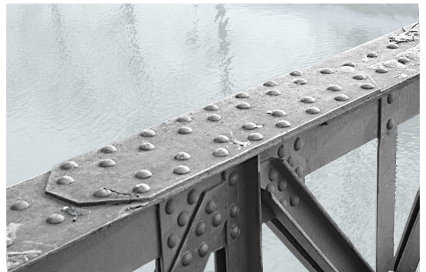
Skarv- och förstärkningsplåt. Bron över Djurgårdsbrunnskanalen, Stockholm. Foto L-G Fredriksson, 2004
