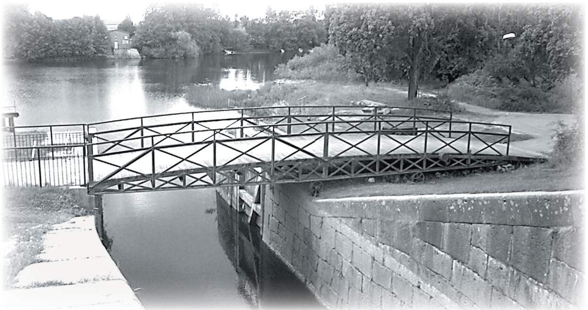
Äldre rullbro över Strömsholms kanal.
