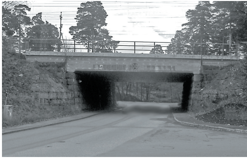
Äldre vägport där ursprungliga stålbalkbron ersatts med en brobana i betong. Södertälje 2004
