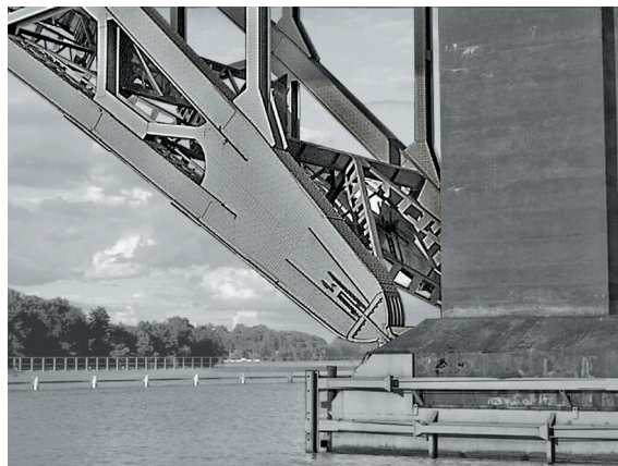
Landfästen och lager till bågbroar. Bron till vänster Västerbron; den till höger Årstabron, båda Stockholm. Foto Västerbron L-G Fredriksson 2003
