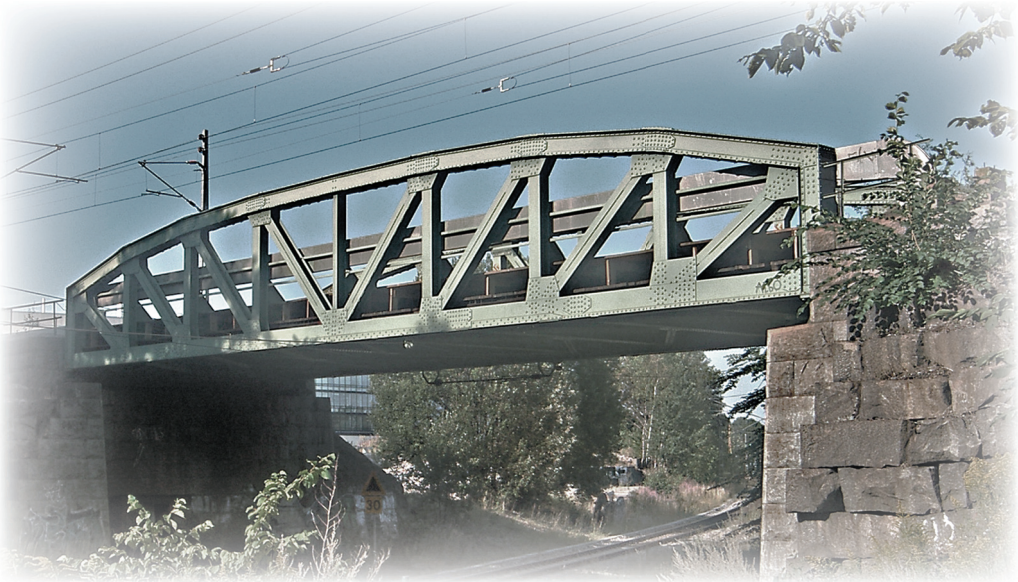
Tvåspårsbro på Roslagsbanan (smalspårig) vid Albano i Stockholm.
