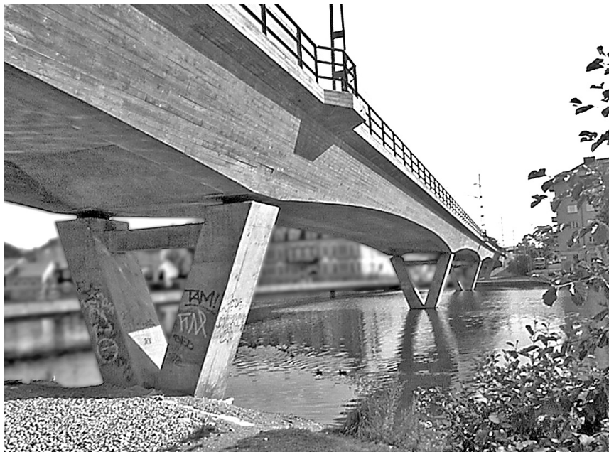
Modern järnvägsbro i betong på Svealandsbanan. Konstruktionen är en ihålig ladbalk; kontinuerlig över bronns hela längd.
