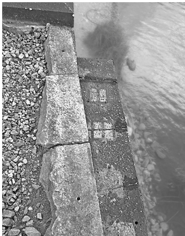
Landfäste till en riven enkelspårig bro. Notera avtrycken på lagerpal-len efter brolagren till fyra huvudbalkar.
