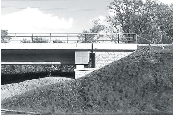
Modern järnvägsbro i betong. T-formad lådbalkbro. Bilden visar bronns upplag med dess fasta lager. Svealandsbanan, Strängnäs 2002
