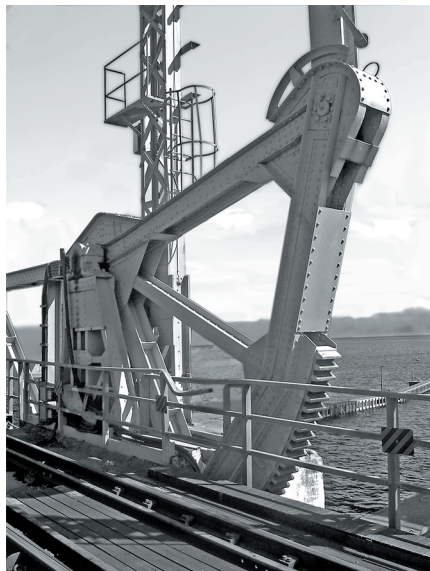
Klaffbro vid Lidingö. Detalj av öppningsmekanismen. Den lodräta strävan uppåt är förbunden med motvikten som balanserar ut broklaffens vikt så att endast mindre krafter behövs för att öppna bron.
