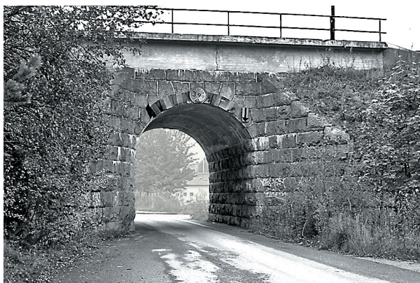
Vägport i natursten. Porten har senare byggts på och förstärkts med ett betongdäck. Dubbelspårslinjen mellan Östertälje och Södertälje.
