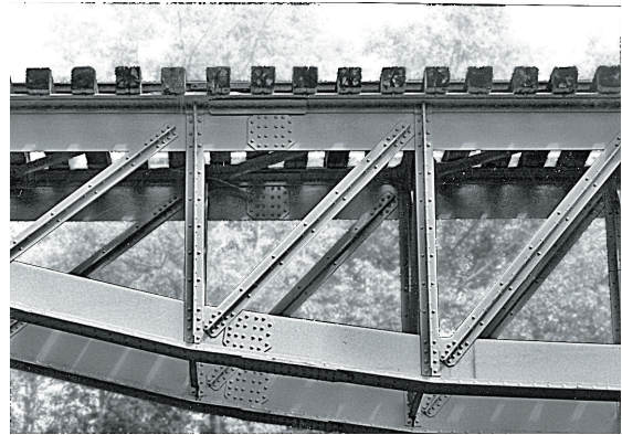
Järnvägsbron vid Järle, NBJ. Detalj av knutpunkter och montageskarvar.
