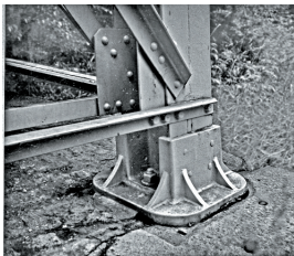
Olika former av brostöd. t.v. Järlebron, t.h. större tysk fackverksbro.
