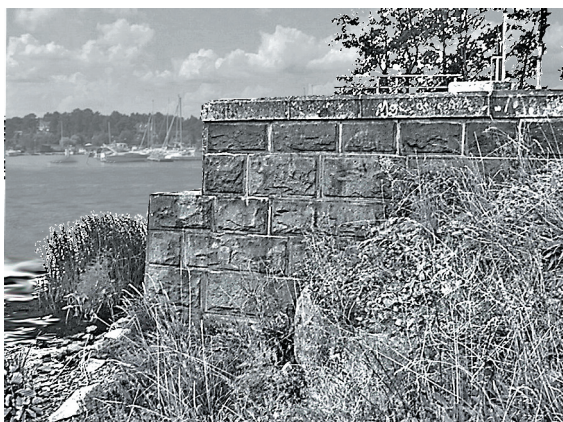
Landfäste till en riven järnvägsbro. Järnvägsbanken som ansluter till landfästet saknar stödmur i och med att banken inte är så hög. Banken har normala lutningar och är gräsbevuxen.
