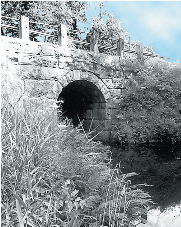
Landsvägsbro i granit.
