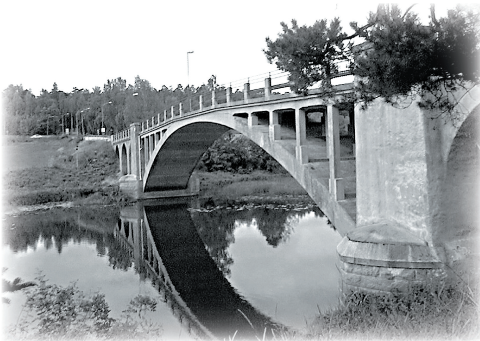
Bågbro i betong med ovanpåliggande brobana. Inspänd massiv enkelbåge. Uppförd 1931. Arboga 2002
