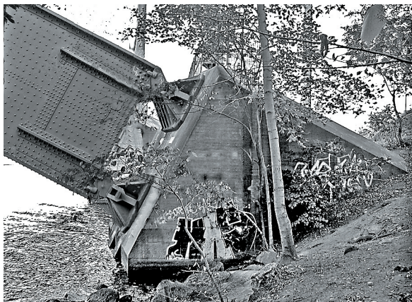
Landfästen och lager till bågbroar. Bron till vänster Västerbron; den till höger Årstabron, båda Stockholm. Foto Västerbron L-G Fredriksson 2003
