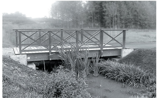
Trägångbro. Brobanan av trä bärs av brobalkar av limträ.
