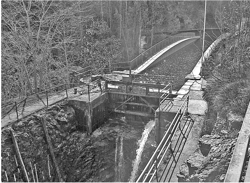
Även en akvedukt är en bro. Denna från Häverud är utförd som en nitad stål balkbro med parabelformad överfläns. Akvedukten ansluter till en sluss i hitre änden. Maj 2005
