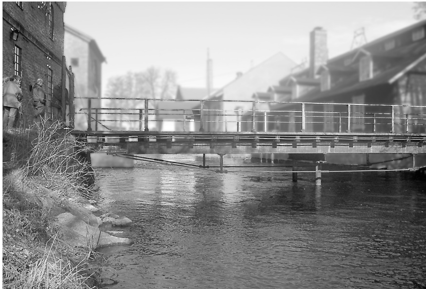
Enkel vägbro utförd av parallella I-balkar upplagd med ett mellanstöd av stål. Notera dragstagen under bron. De är till för att kunna öka tillåtna belastningen utan att öka dimensionerna på balkarna (eller ytterligare ett stöd under bron). Forsviks bruk, Västergötland. April 2005
