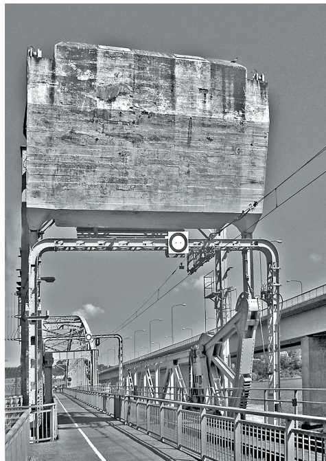
Klaffbron mot Lidingö. Motvikt av betong. I bakgrunden den ej öppningsbara bågbron.
