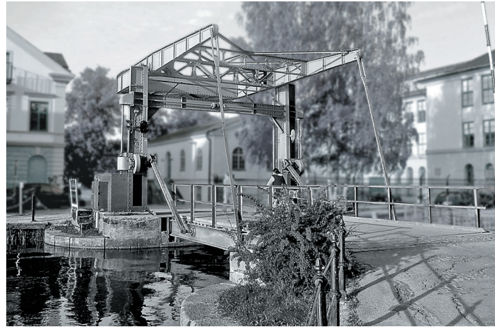
Klaffbro av holländsk typ. Bro vid kanalslussen i Eskilstuna. I bakgrunden Faktoriholmarna.
