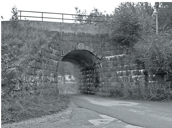
Två äldre broar i natursten där bankroppen har höjts och broarna förstärkts med ett betongdäck.
