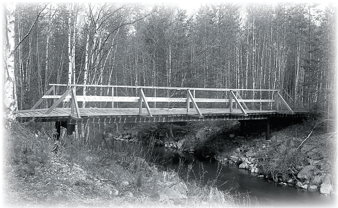
Enklare träbro byggd av fyra långgående telefonstolpar med plankdäck.
