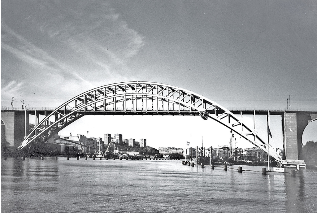
Årstabron. Bågbro i stålfackverk. Se även Årstabrons lyfibrö i kapitlet om Rörliga broar.
