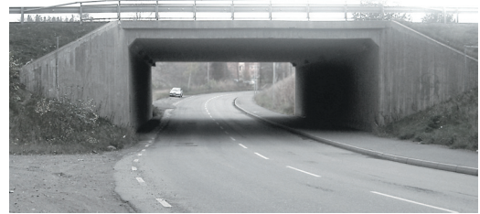
Rambo i betong. Lokalgata under motorvägen E4 i Södertälje.
