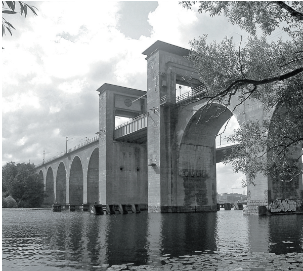
Lyftspann på Årstabron, Stockholm. Spannet är numera taget ur bruk.
