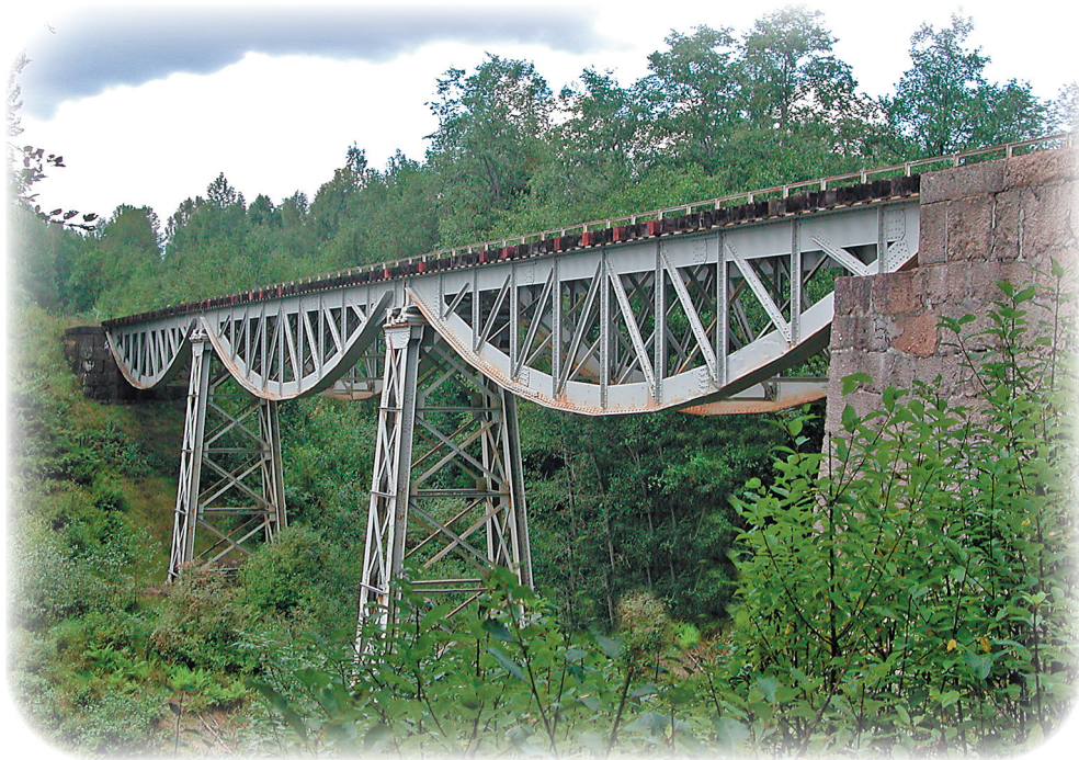
Äldre järnvägsbro över Järleån på NBJ strax norr om Järle station.
