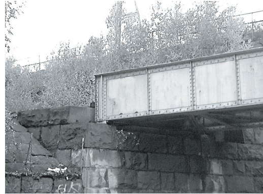
Glidlager till en kort plåtbalkbro. Själva lagret är en kraftig metallplatta som brobalken vilar på. Södertälje 2005
