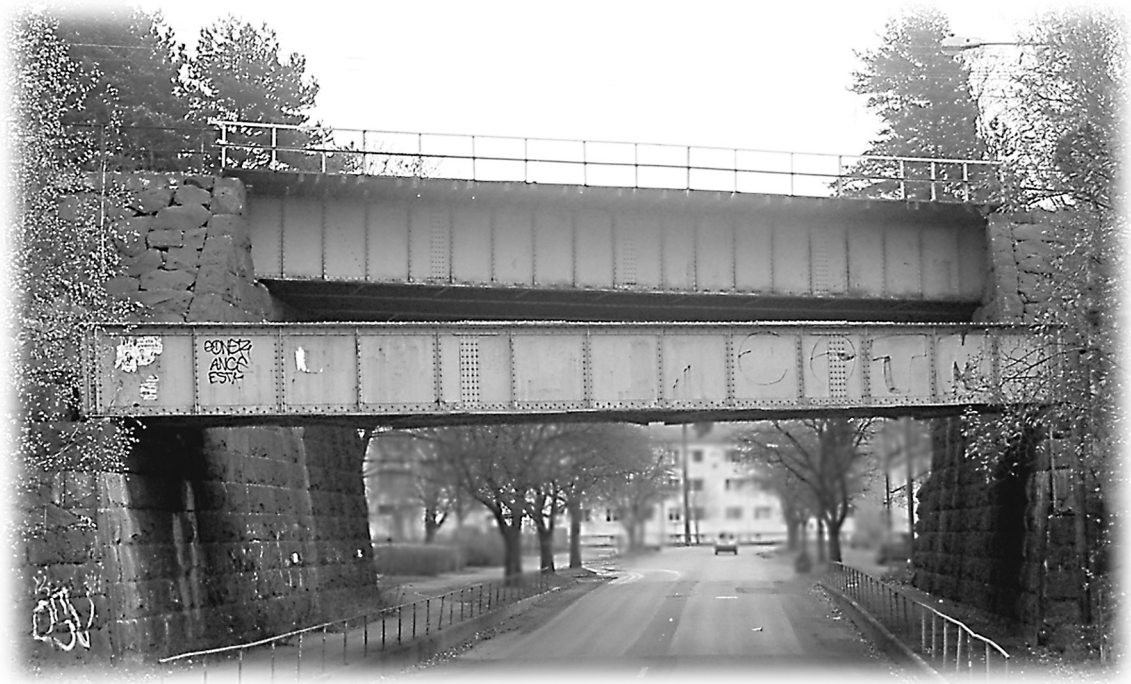
Balkbroar i Södertälje. Den övre bär dubbelspåret till Stockholm. På den undre går sidolinjen från Södertälje hamn ner till Södertälje C.
