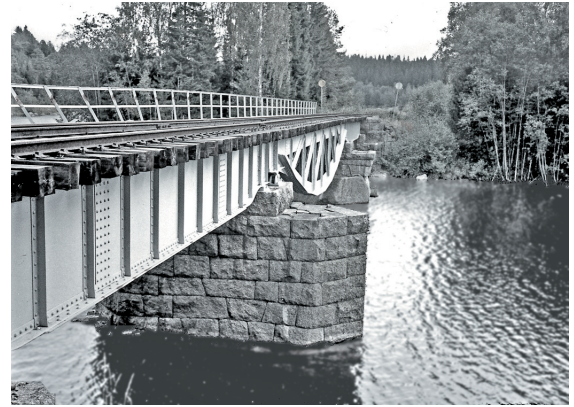
Mellanstöd i huggen granit till järnvägsbro (NBJ) i flera spann. Mellan de båda plåtbalkbroarna ligger en fackverksbro med parabelformad båge. Stöden har en spetsig ände för att hindra dämning vid islossning.
