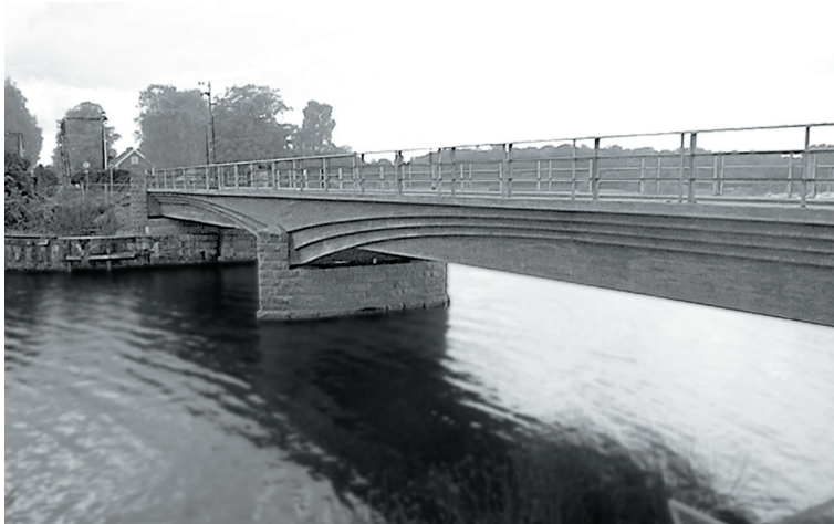
Järnvägsbro i betong. Detta är en normal balkbro även om designen tar upp former från bågbroarna. Att det är en balkbro framgår bl.a. av hur upplagen ser ut. Här är det bara "vanliga" lager för i huvudsak vertikala krafter.
