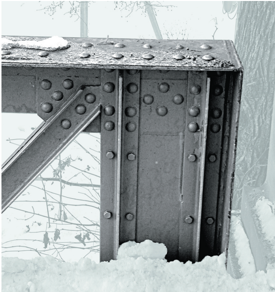
Utformning av broände på äldre fackverksbro avsedd för landsvägstrafik. Bron har klens korsande diagonaler mellan vertikallerna i huvudbalken.
