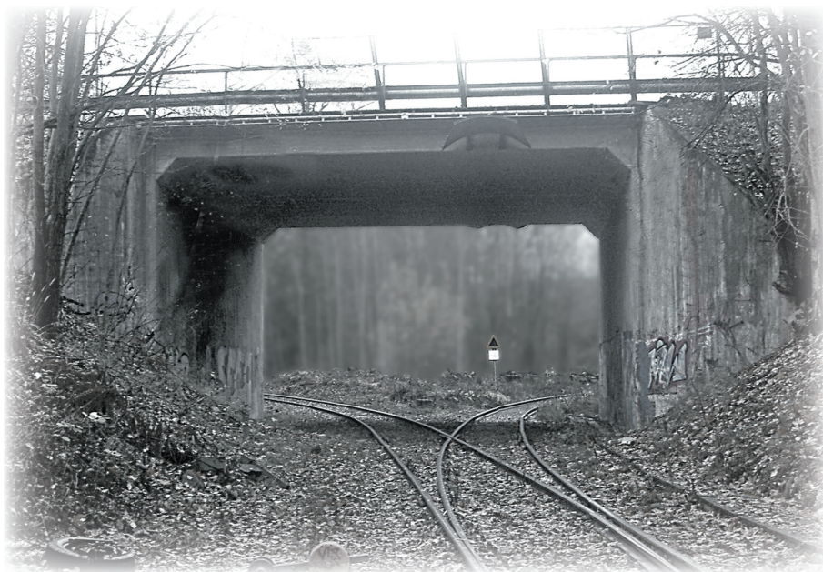
Rambro i betong över hamnspåren i Södertälje hamn.
