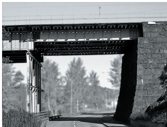
Landfäste av granit och mellanstöd i sackverkskonstruktion.
