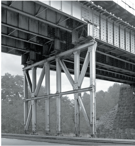
Landfäste av granit och mellanstöd i fackverkskonstruktion.
