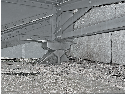
Fast lager till fackverksbro. Notera att lagret är fastbultat även i landfästet. Järlebron 1992
