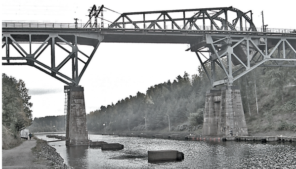
Järnvägsbron över Södertälje kanal. Bron är en klaffbro med underliggande motvikt. Notera de mycket höga mellanstöden. Sept 2004
