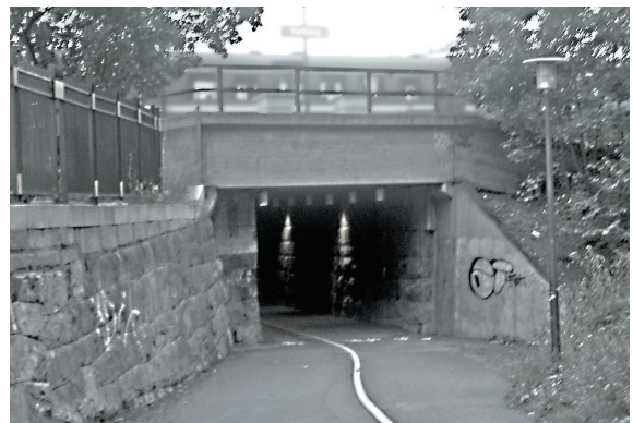
Vägport som moderniserats med ny brobana i betong. Karlberg, Stockholm. 2004
